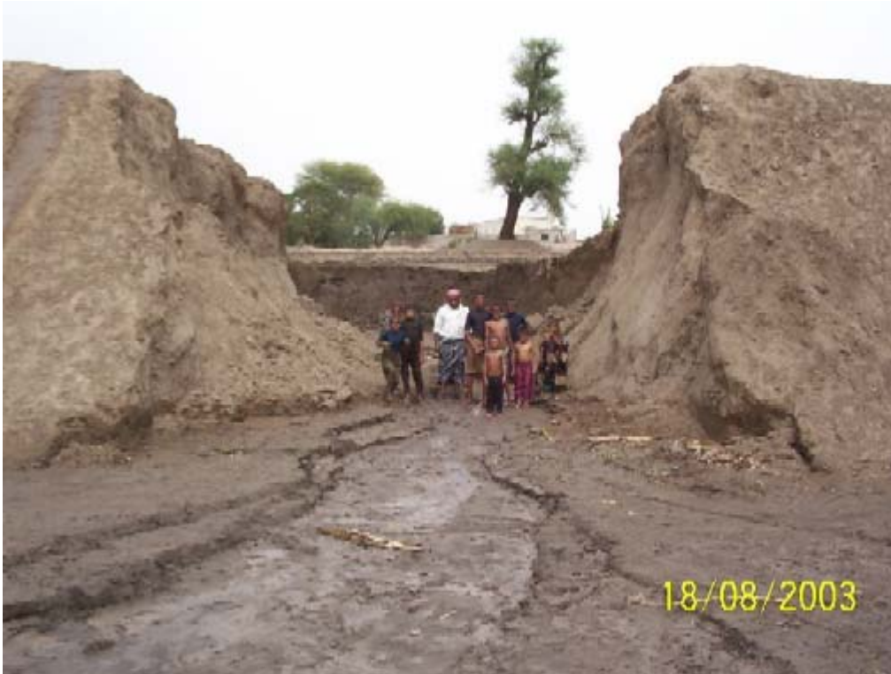
صورة : 39 انهيار معقم الأشراف على شريح الجرهي.(بوادي زبيد)
