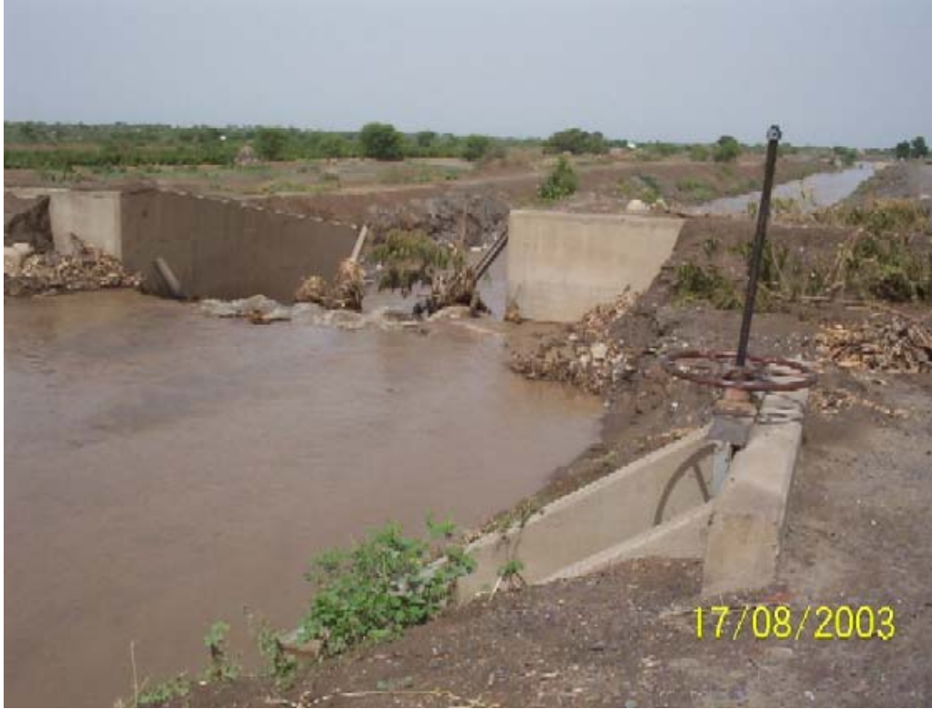
صورة : 30 سد مسقط المياه في إحدى قنوات وادي زبيد لري الأراضي المعلقة (ذات المناسيب المرتفعة)
