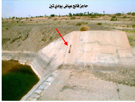
صورة : 47 انتزاع مساطر قياس تدفق السيول Staff Gauges
