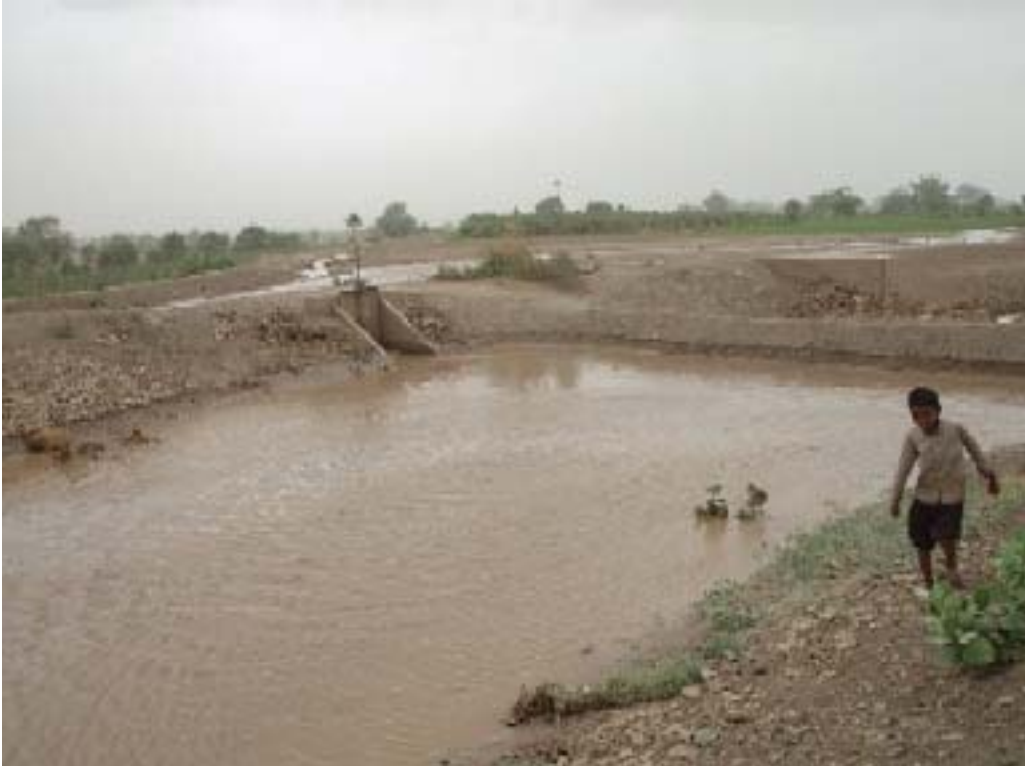
صورة : 33 بناء العقوم الترابية داخل القنوات الرئيسية و تحويل المياه هي أيضا أحد صور المخالفات و عادةً تكون من قبل كبار الملاك
