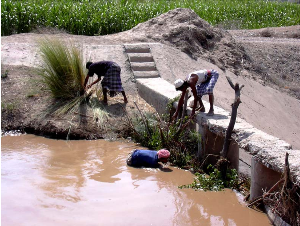
صورة : 30 سد مسقط المياه في إحدى قنوات وادي زبيد لري الأراضي المعلقة (ذات المناسيب المرتفعة)
