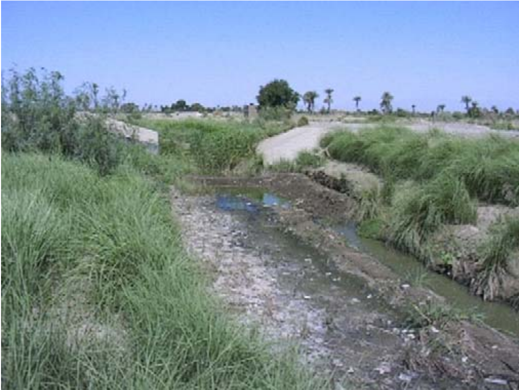
صورة : 45 قناة ثانوية تم ربطها ببركة جمع مياه المجاري لتوصيلها إلى الأراضي الزراعية و استخدامها في الري (الحوطة م/لحج)
