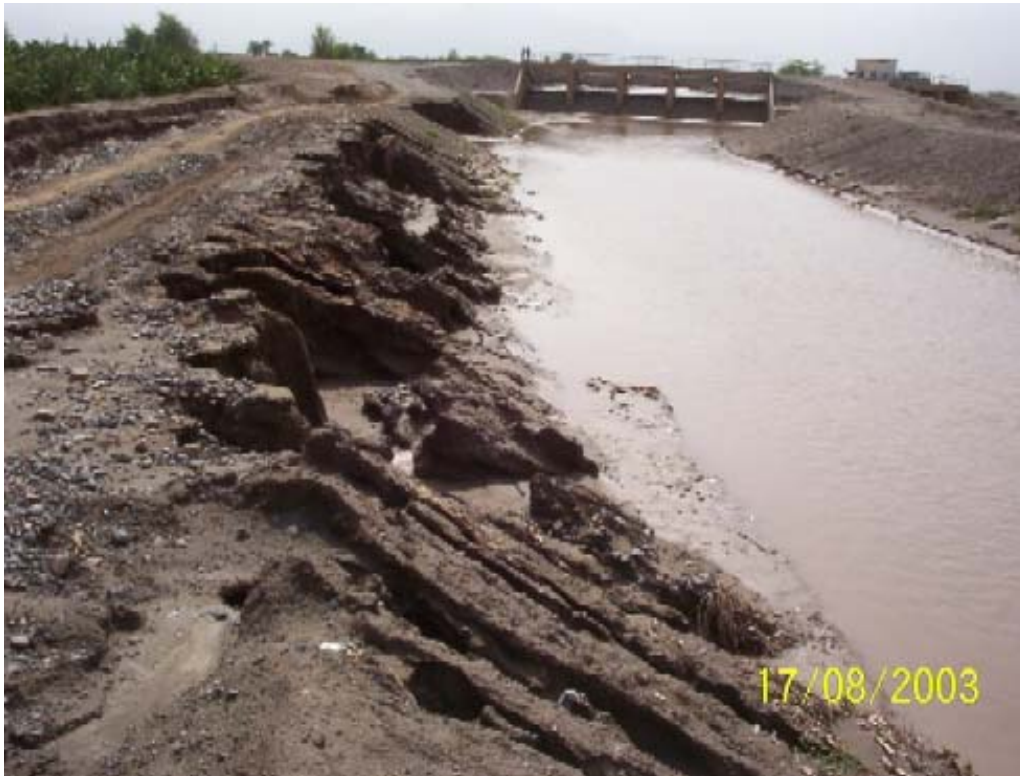
صورة : 35 انجراف أكتاف و جسم القناة و طريق التفتيش بفعل الري الجائر و تحويل المياه عن مجاريها بوادي زبيد
