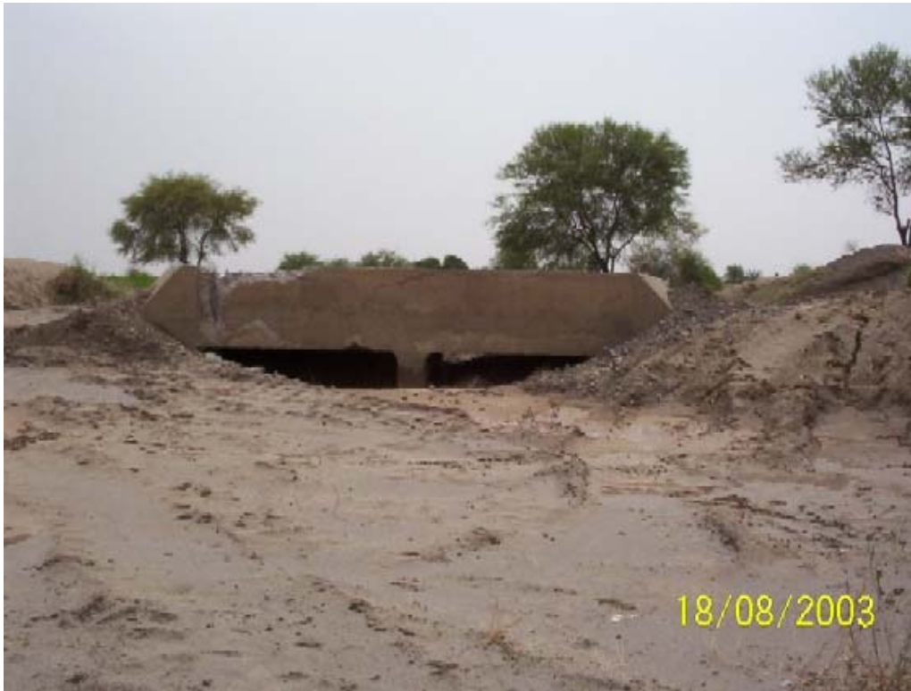
صورة : 23 تراكم الطمي و انسداد عبارات المياه (وادي زبيد)
