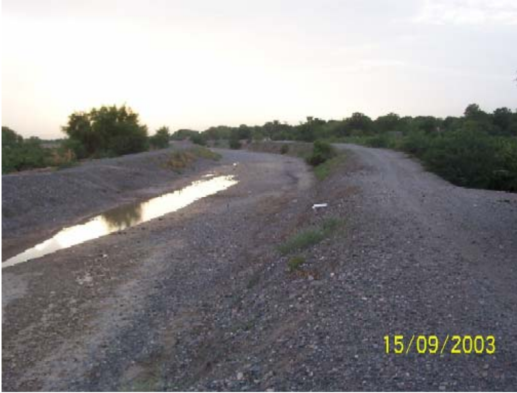
صورة : 22 تراكم الرسوبيات الخشنة و الطمي في القنوات و الشرج بوادي زبيد (شريج الماوي بوادي زبيد)
