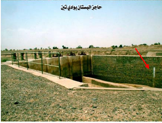
صورة : 47 انتزاع مساطر قياس تدفق السيول Staff Gauges
