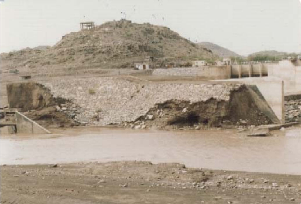
صورة : 13 جرف بعض المنشآت الرئيسية (حاجز واقر وادي سهام) بفعل السيول وغياب التشغيل السليم للحاجز
