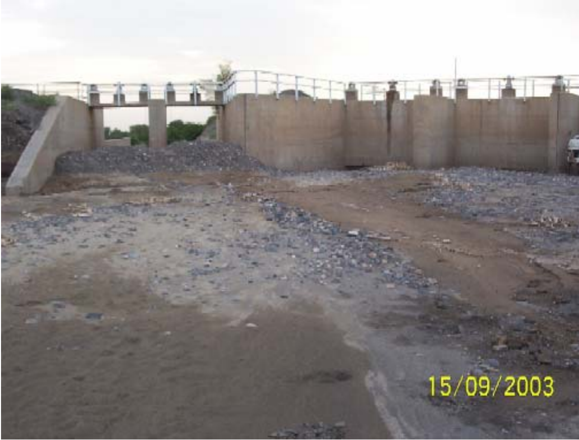
صورة : 28 سد بوابات التصفية تعتبر من اكبر المخالفات بوادي تبين
