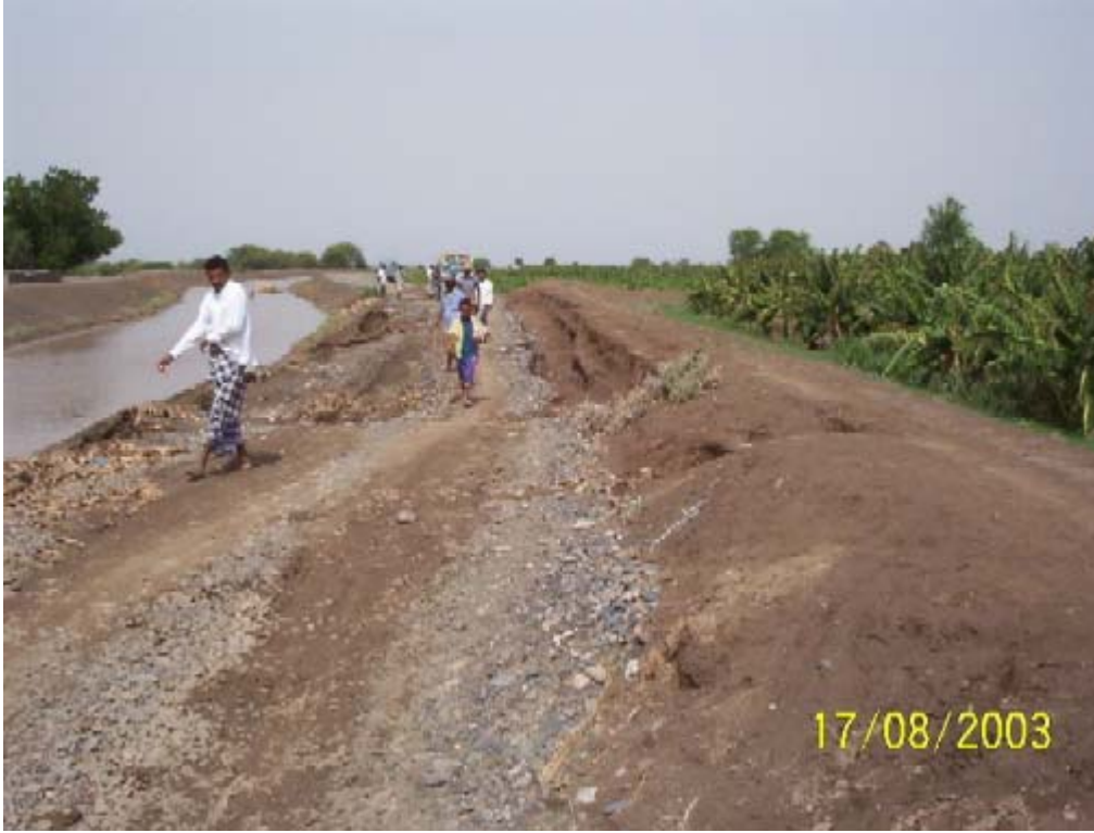
صورة : 38 انجراف إحدى طريق التفتيش بفعل الري الجائر (وادي تين)
