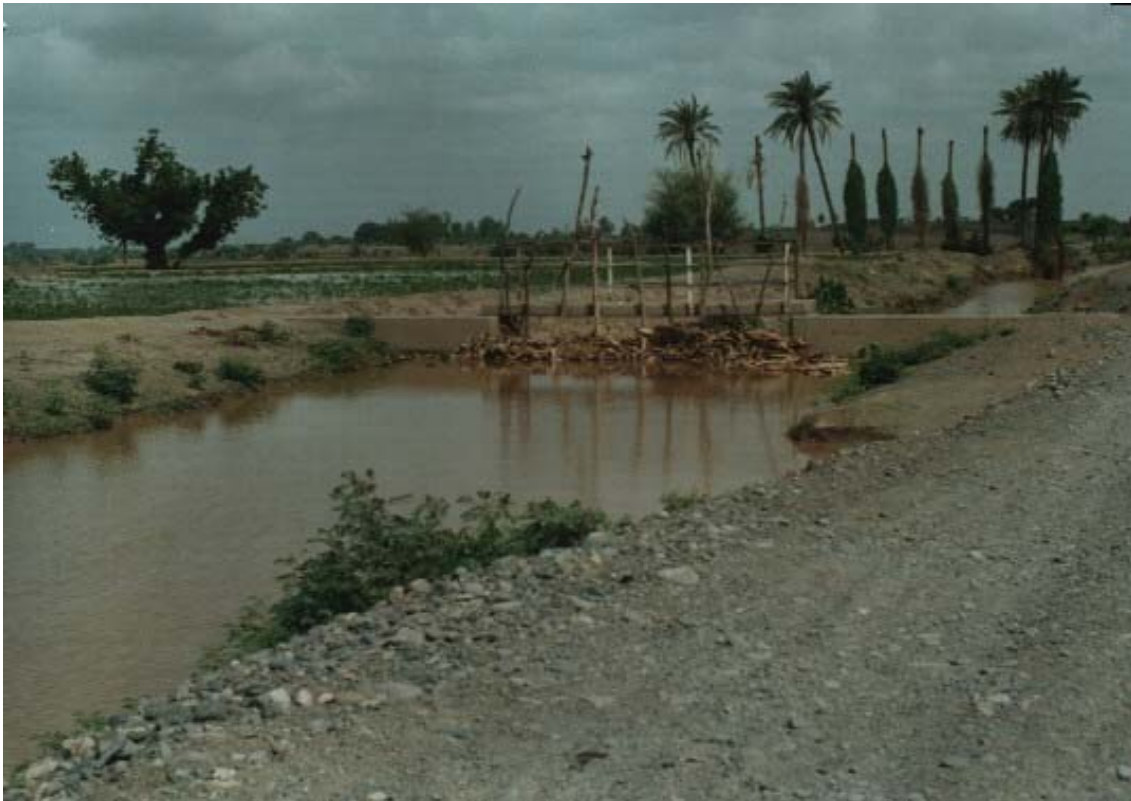
صورة : 29 يتم سد القنوات بالأخشاب و أكياس الرمل لجعل ألقناه تمتلئ و تطفح المياه من ضفافها و تروى الأراضي ذات المناسيب المرتفعة الأمر الذي يؤدي إلى تهدم القنوات و تعريض منشآت الري و الأراضي الزراعية للانجراف .....
